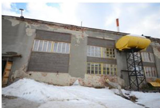
Рисунок 4.1 Здание котельной Аэропорт
